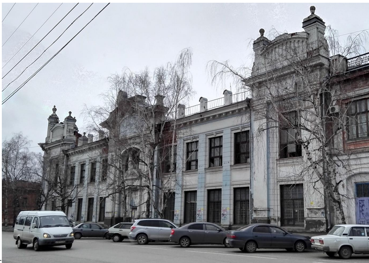
3. Юго-восточный фасад. Фото 2021 г.
