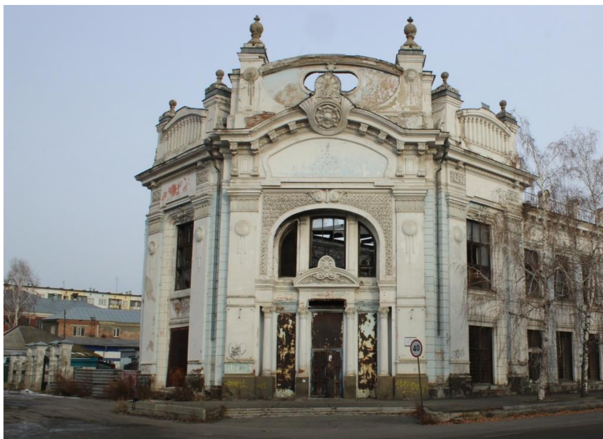
4. Северо-восточный фасад, угловая часть здания. Фото 2021 г.
