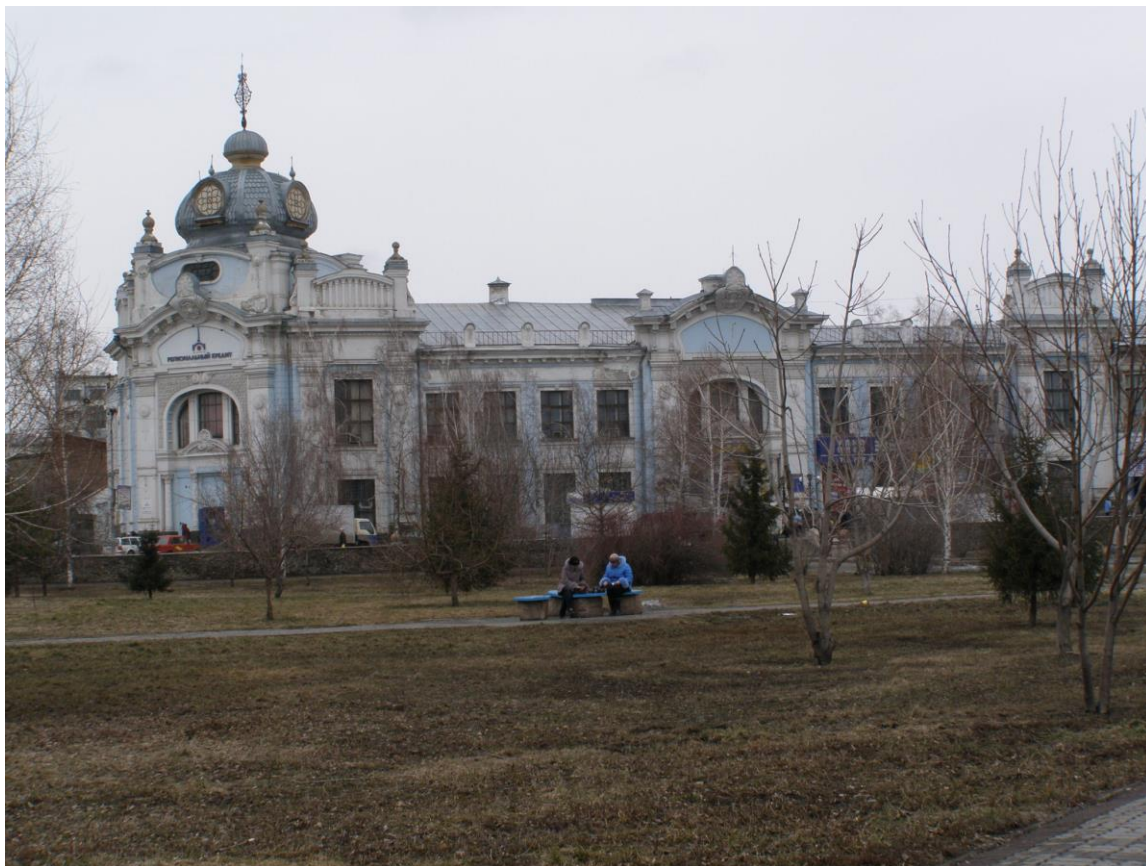
1. Главный юго-восточный фасад (по ул. Льва Толстого). Фото 2007 г.
