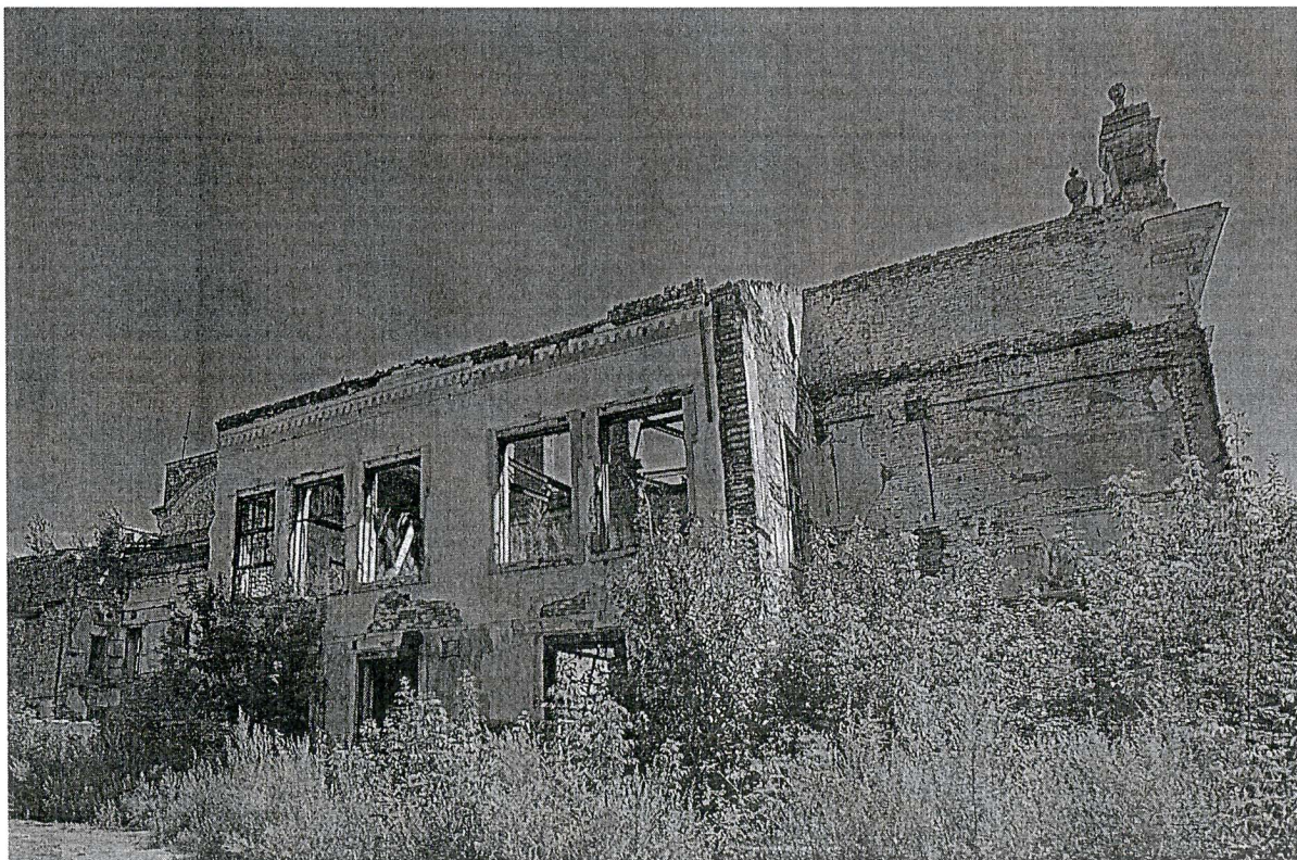
Фото 4 от 07.05.2025. Вид со стороны дворового северо-западного фасада.
