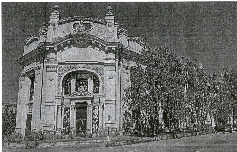
Фото 2 от 07.05.2025. Общий вид (главный фасад).
