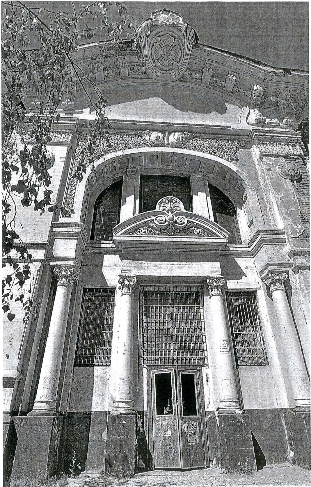
Фото 7 от 07.05.2025. Вход с ул. Л. Толстого.
